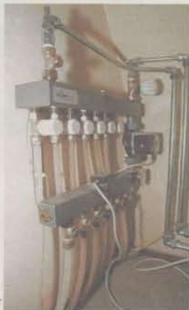
De slangen voor de vloerverwarming gaan de grond in.
